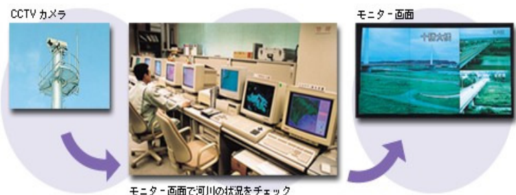
CCTVのイメージ
