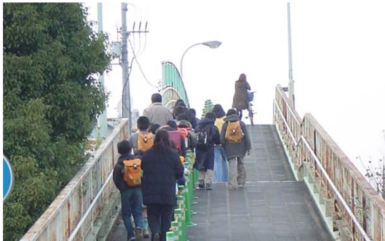
現在の横断陸橋の状況
