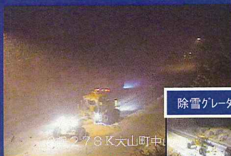
除雪グレーダによる除雪状況
