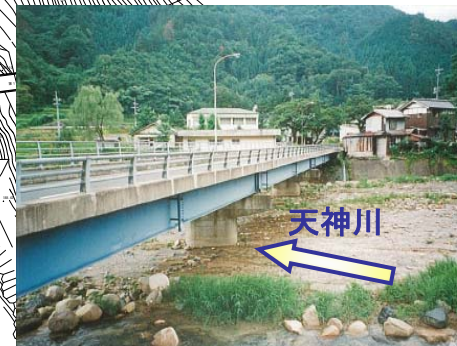
平常時（復旧後）
