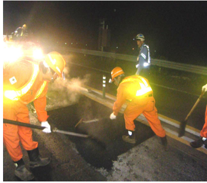
路面補修作業(例)
