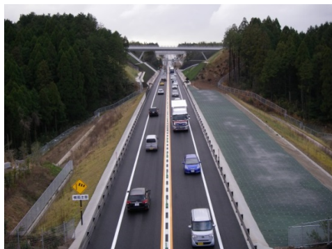
開通直後の利用状況 (大山町下市から米子方面を望む)
