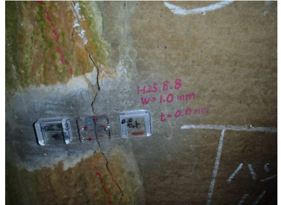
写真-2 簡易ひび割れ変位計設置状況
