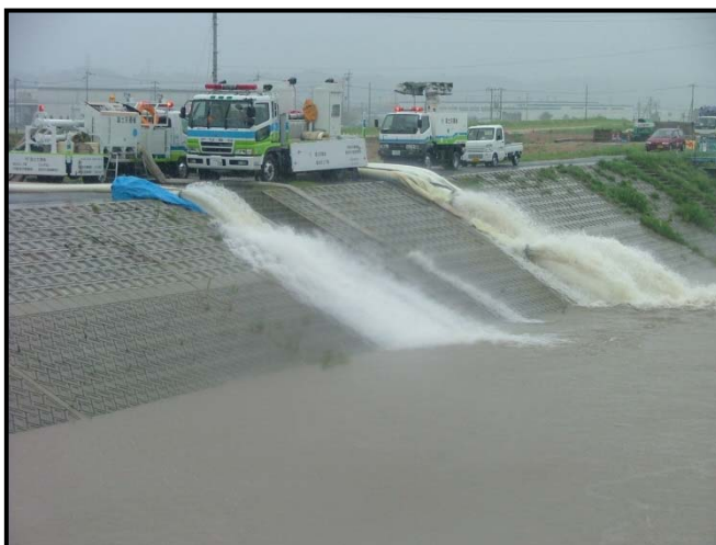
平成23年度台風12号(倉吉市西福守) 排水ポンプ車で内水排除作業
