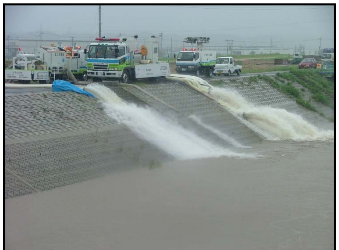
平成23年度台風12号(倉吉市西福守) 排水ポンプ車で内水排除作業
