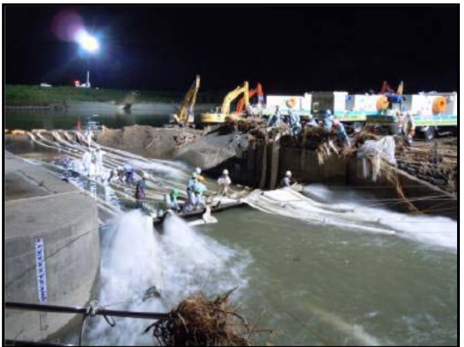
平成23年度台風12号(倉吉市西福守) 排水ポンプ車で内水排除作業
