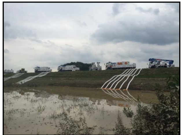
平成23年3月~5月 東日本大震災 排水ポンプ車で内水排除作業
