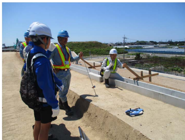
道路工事現場見学
