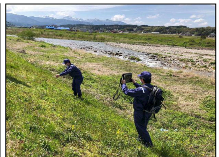
堤防点検の様子
