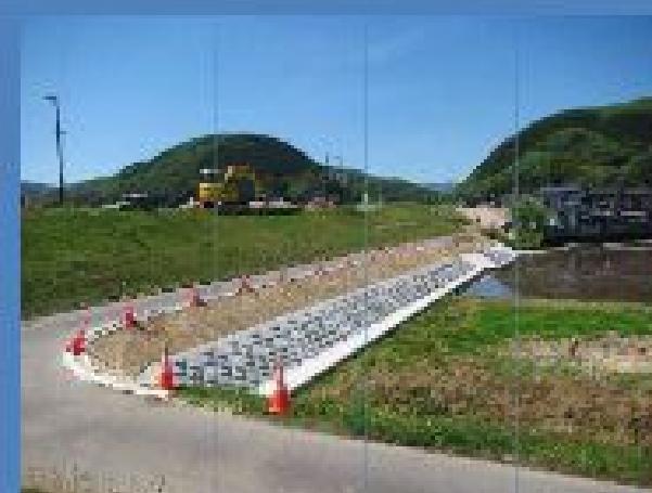
西城川 左岸 寺戸地区 施工状況
