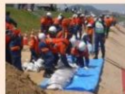
改良積土のう工法
