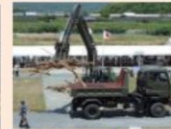
流木撤去訓練
