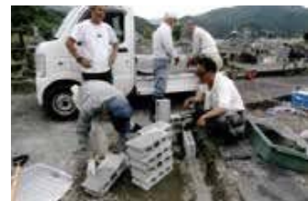
避難路拡幅作業
