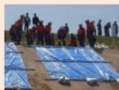
シート張り工
