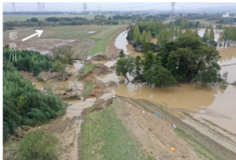
都幾川0.4k右岸 決壊箇所
