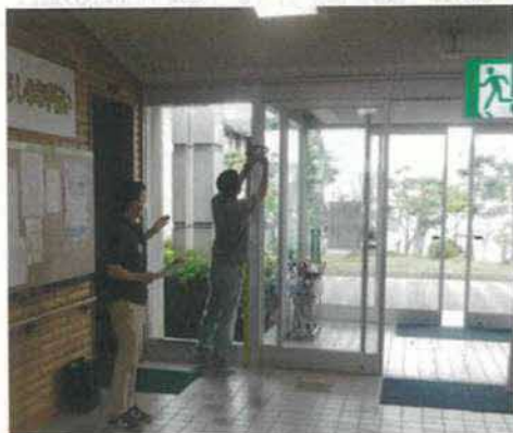
<想定最大浸水深（約2m）を明示し確認>
