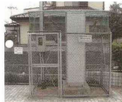
観測装置設置状況
