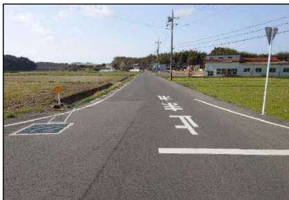
島嶼道線(施工前)
