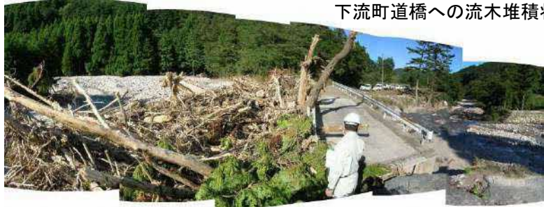
下流町道橋への流木堆積状況
