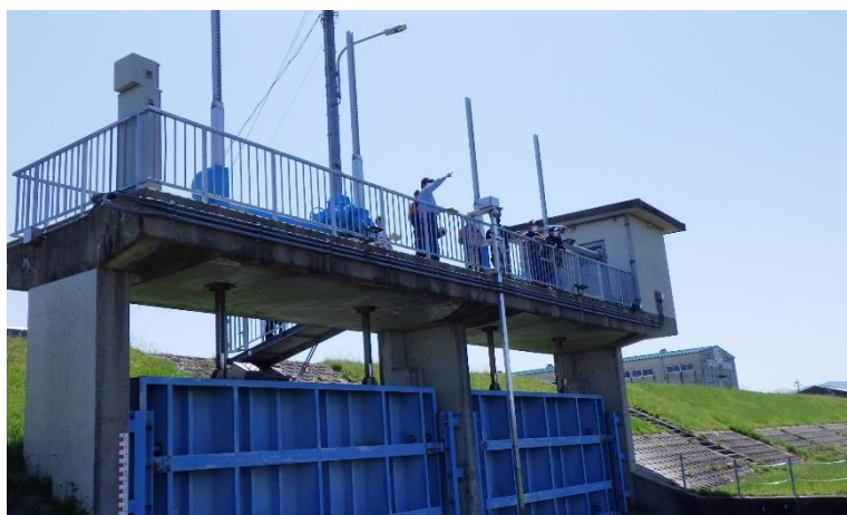
合同点検の様子
