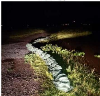
岩木川左岸（野木地先） 積み土のう工
