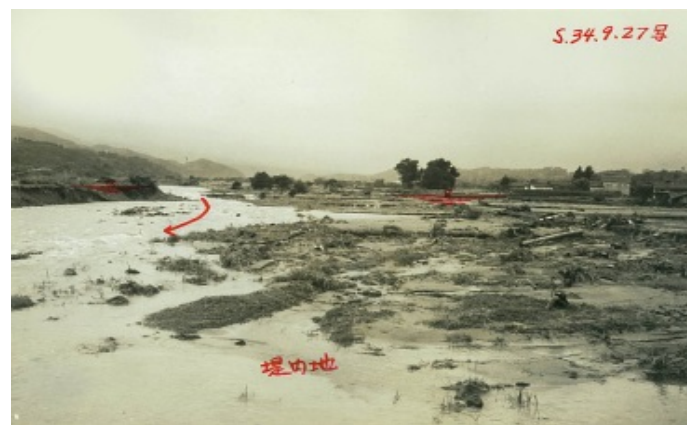
昭和34年伊勢湾台風洪水 倉吉市関金地区の破堤状況
