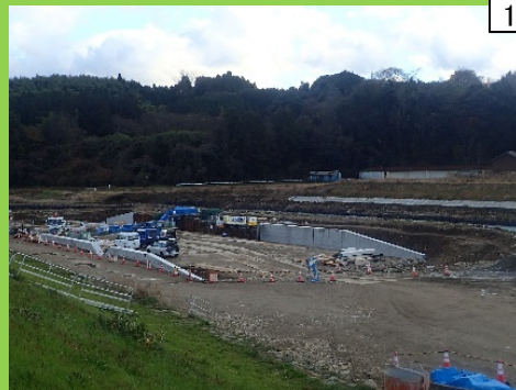
国府川米積箇所での流下能力対策(オヶ崎堰改築)
