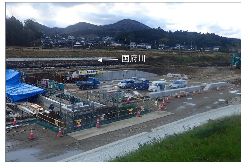
オケ崎堰の施工状況(平成30年12月現在)
