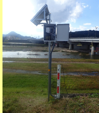
計20箇所設置(倉吉大橋付近(7.1k)の設置事例)
