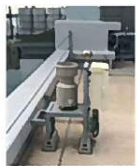
屋上へ雨量計設置
