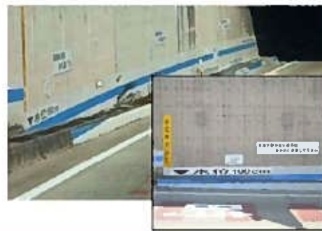
2 アンダーパス道路側面への水位表示 (名古屋国道事務所)
