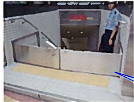
止水板、水防扉の設置
