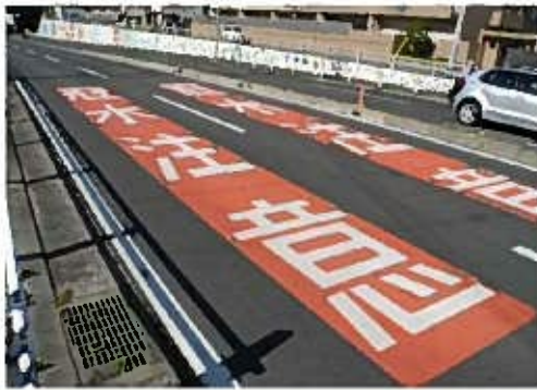
1 道路冠水想定箇所の路面に注意喚起 (愛知県)
