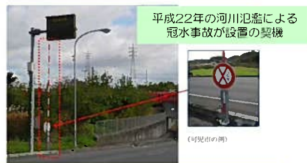
4 道路冠水想定箇所に遮断器 (さお型) を設置 (可児市)
