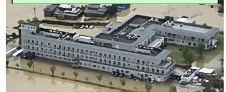
令和元年8月の大雨で浸水した順天堂病院（佐賀県）
