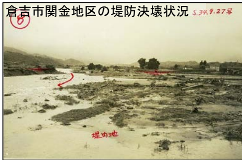
倉吉市関金地区の堤防決壊状況 S.34.9.27号 【昭和34年9月伊勢湾台風洪水】 (戦後最大洪水)
