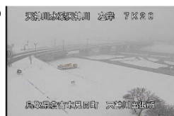
(CCTV) 天神川出張所
