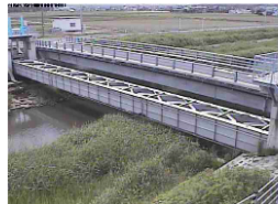
(県河川) 北条川放水路 (浜川水路橋)
