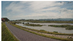
(簡易型) 天神川1k600左岸 新天神橋
