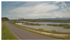
(簡易型)天神川1k600左岸 新天神橋
