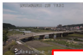
【CCTV】天神川出張所(天神川17.2K左岸)
