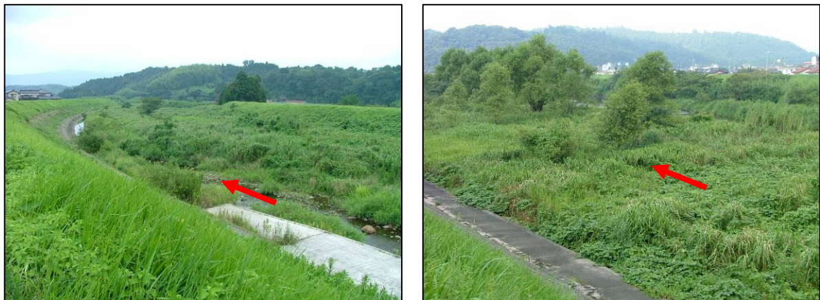
図 2.3 現況写真(樹木繁茂、みお筋の固定化)
