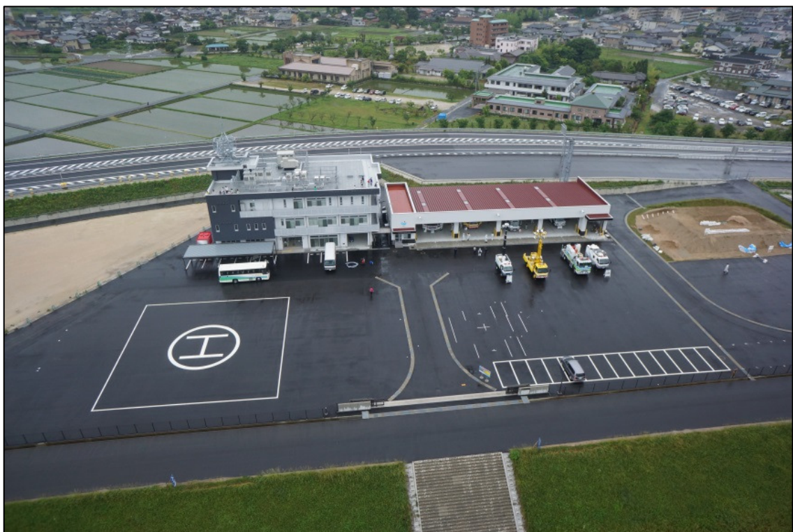
図 7.2 天神川河川防災ステーション
