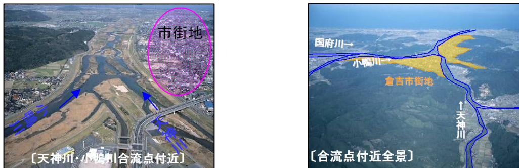
図 3.1 天神川との合流部
