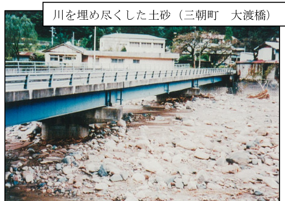
図 2.7 平成10年台風10号による被災状況
