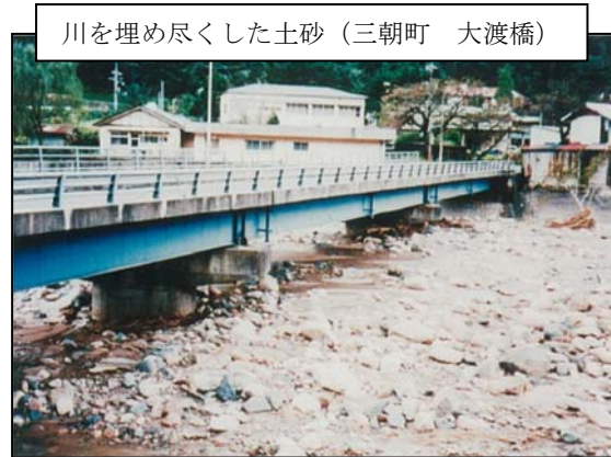
図 2-8 平成10年台風10号による被災状況
