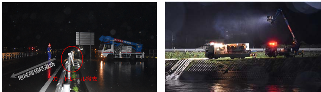
図 2-5 内水対策状況 H30.9(国府川右岸 1k700)
