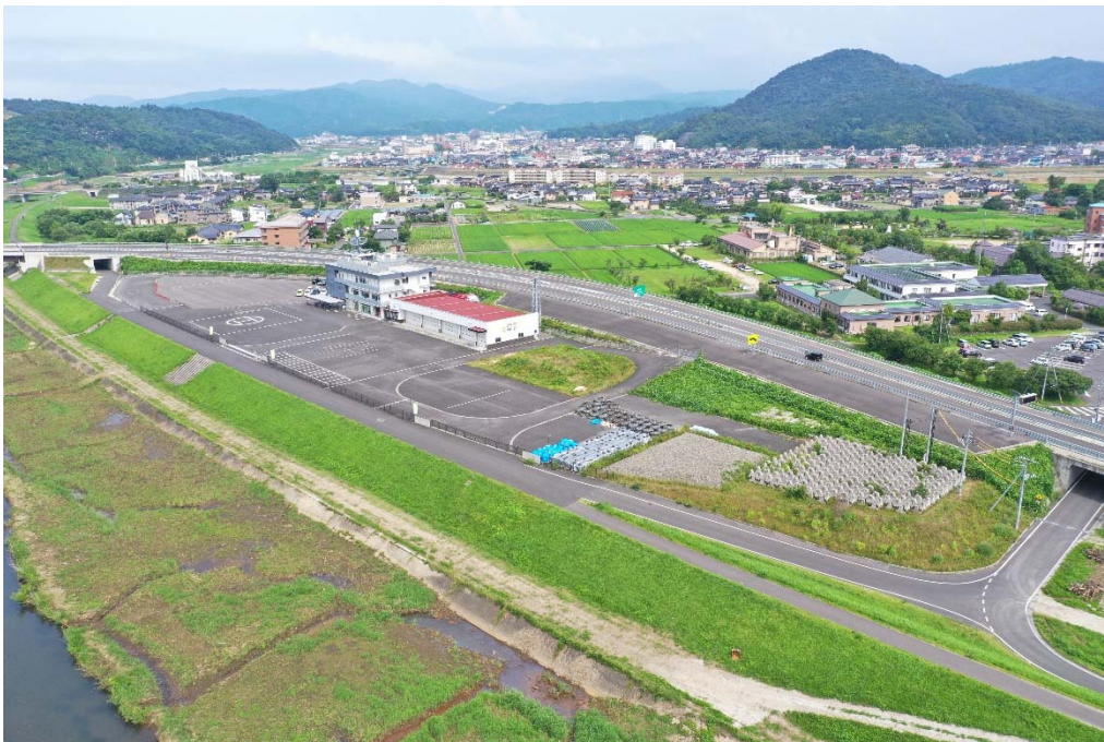
図 7-1 天神川河川防災ステーション
