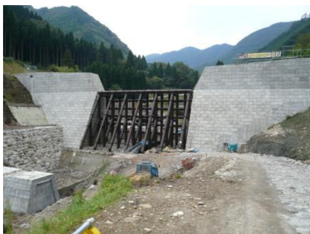
工事が進む小泉2号砂防堰堤
