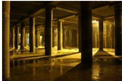
大規模地下貯留施設(下水道)
