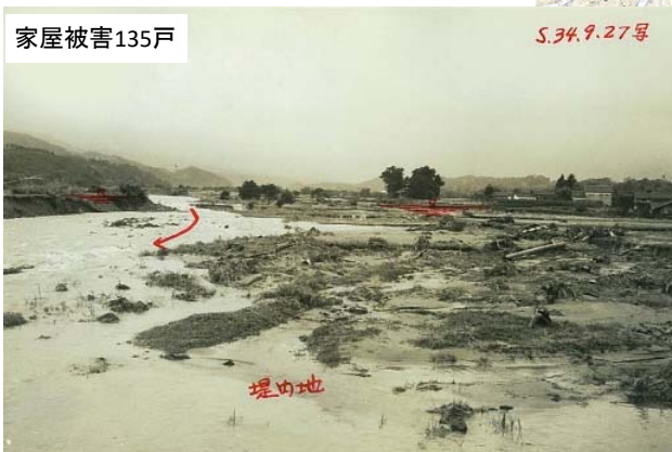
昭和34年伊勢湾台風洪水 倉吉市関金地区の破堤状況
