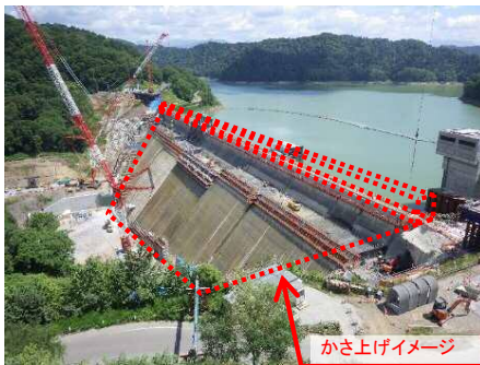
ダム建設・ダム再生
