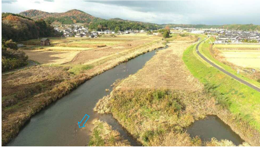
着手前状況（米積地先：H29.10）
