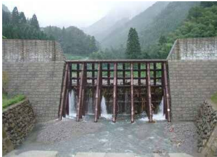
▲小泉2号砂防堰堤の土砂・流木補足状況 (2011(H23)年9月出水時)
