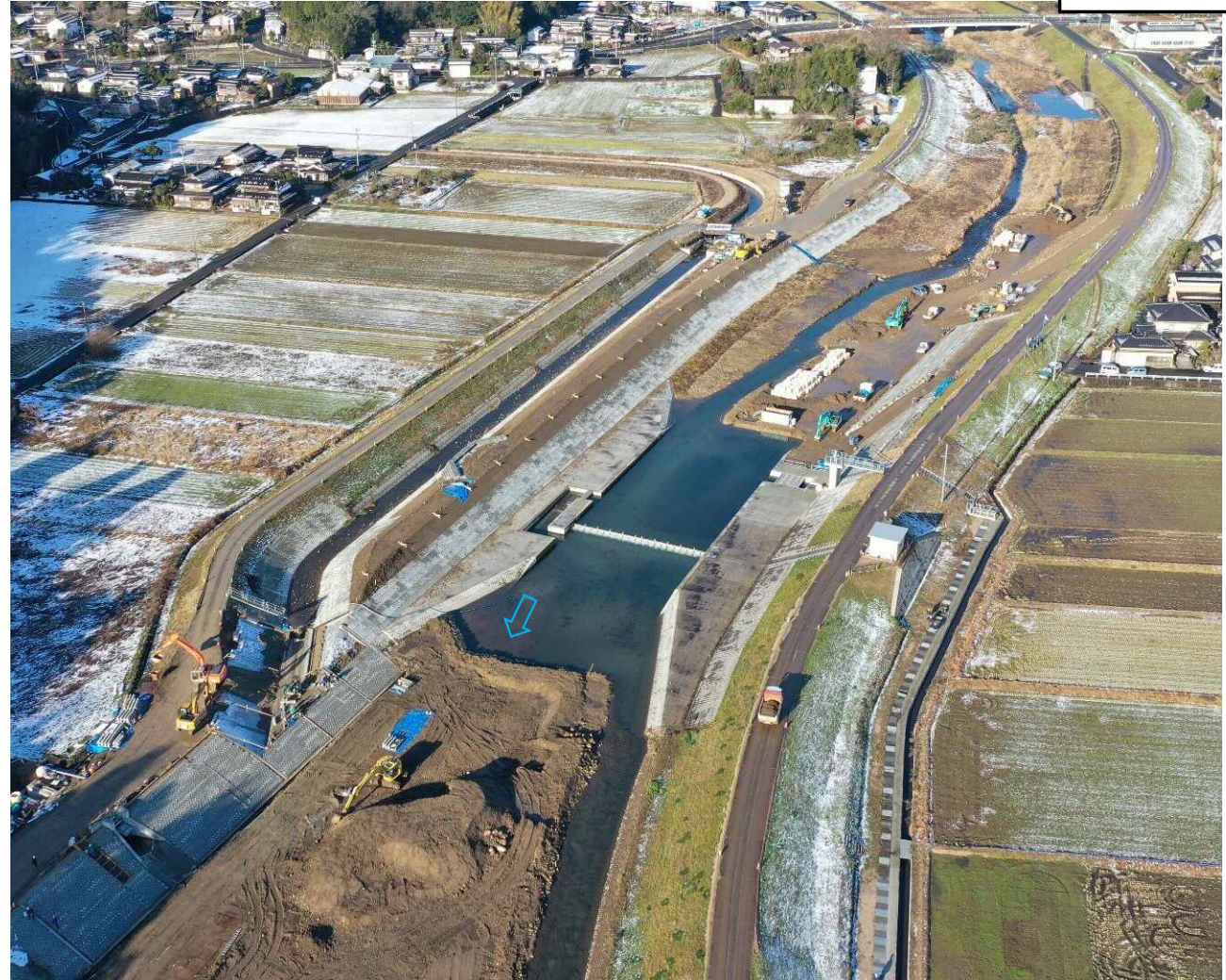
現在状況（米積地先：R3.1）
