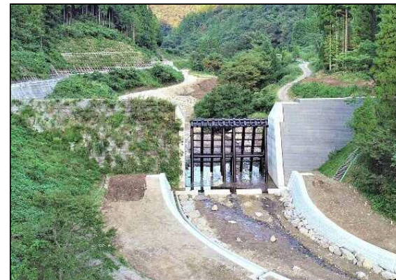
▲吉田砂防堰堤 (2019(R1)年9月完成)
