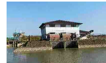
(排水機場整備)
