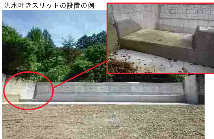
洪水吐きスリットの設置の例
