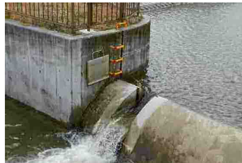
洪水吐きスリットの設置の例
