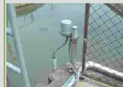
水位計の設置
