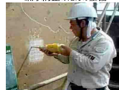
老朽化した施設の機能診断
