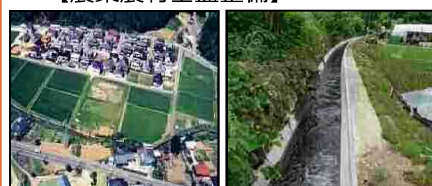
は場整備による農業生産性の向上と秩序ある土地利用の推進 老朽化した用水路の整備・更新
