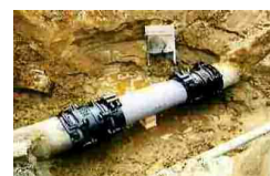
漏水防止のための整備
