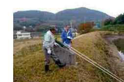
ため池の現地パトロール
