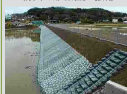
ため池護岸の整備
