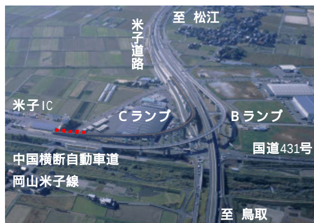
米子JCT上空より松江方面を望む
