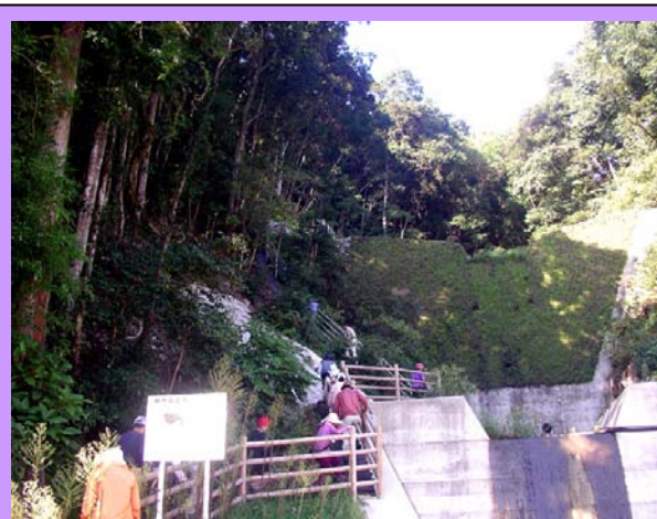
三朝の温泉街・住宅地のすぐ近くに作られた向沢田砂防堰堤を見学しました。堰堤のコンクリートが露出せず、植物で覆われるようにして環境に配慮したのになっています。
