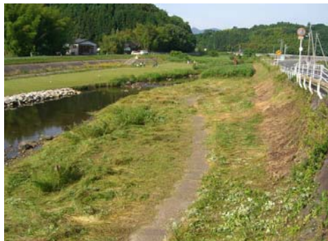
上福田橋上流 左岸
