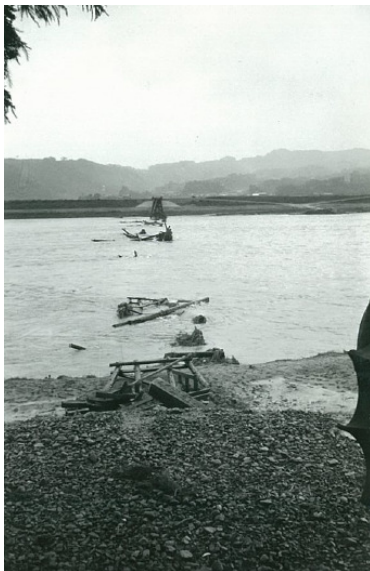
昭和34年伊勢湾台風洪水 大塚橋の流失状況
