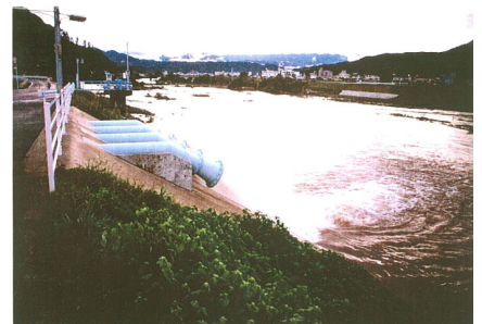
平成10年10月台風洪水 倉吉市和田地区の排水機場稼働状況
