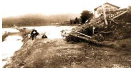
昭和9年室戸台風洪水 旧倉吉中学校裏の惨状
