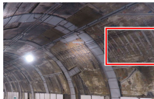
【写真②】赤名トンネルにおける車両の接触による損傷
