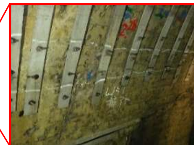
【写真②】赤名トンネルにおける車両の接触による損傷
