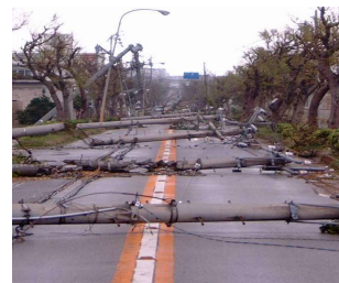
<電柱の倒壊による道路閉塞の事例>
