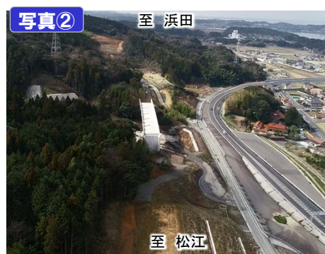
東神西第1高架橋
