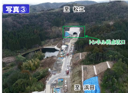
神西トンネル付近
