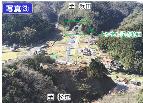
神西トンネル付近
