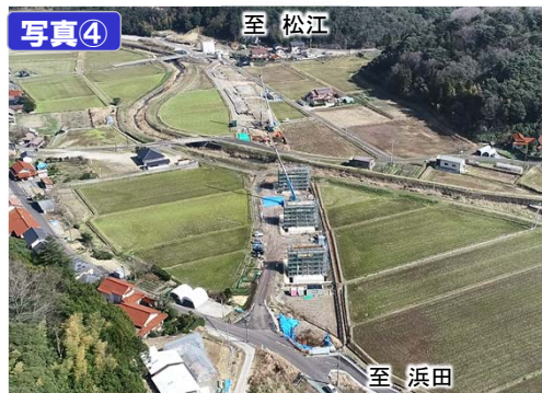
常楽寺第二高架橋付近
