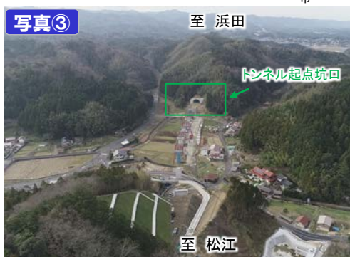
神西トンネル付近
