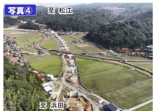
常楽寺第二高架橋付近
