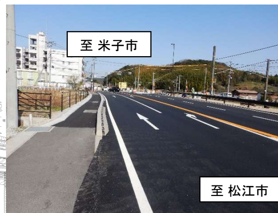
写真①: 交差点改良後の状況
