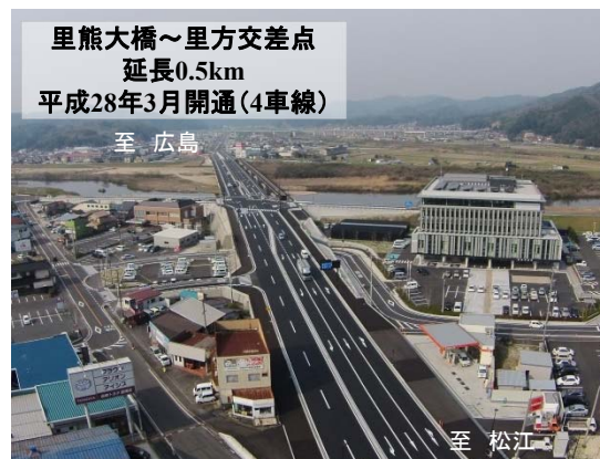
里熊大橋 広島方面を望む
