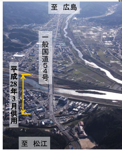
上空より里熊大橋周辺を望む
