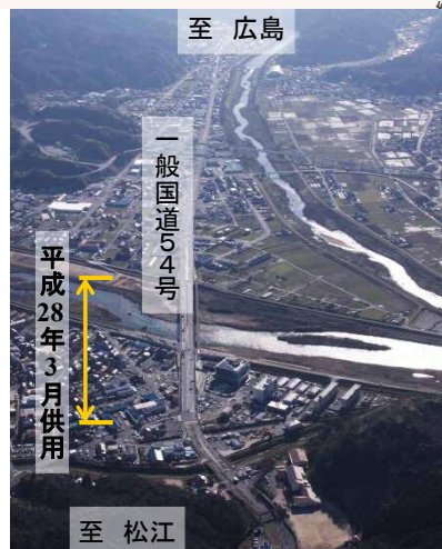
上空より里熊大橋周辺を望む
