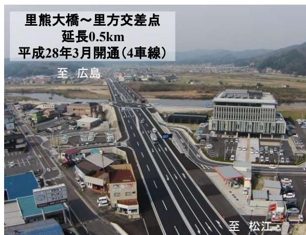
里熊大橋 広島方面を望む
