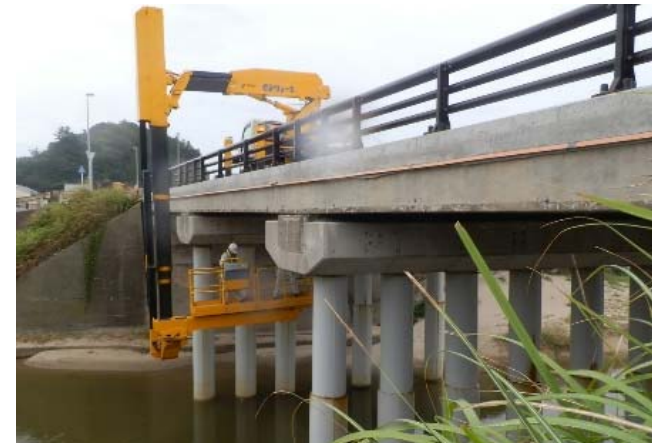
橋梁点検の様子
