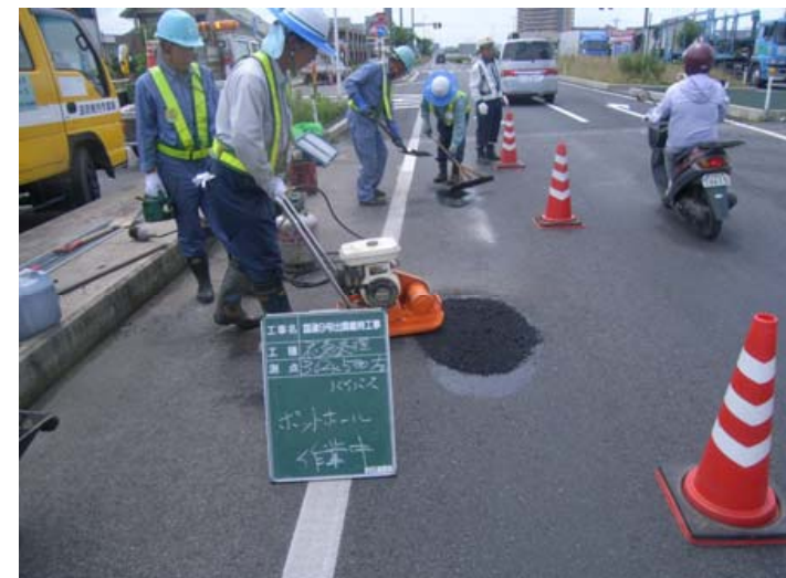
舗装の応急補修（ポットホール補修）
