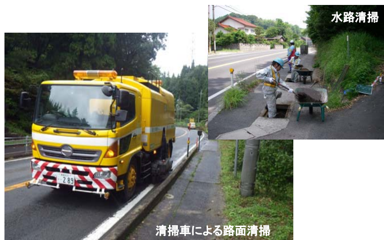
道路清掃作業（9号、54号は1回／年、松江道路は4回／年程度実施）
