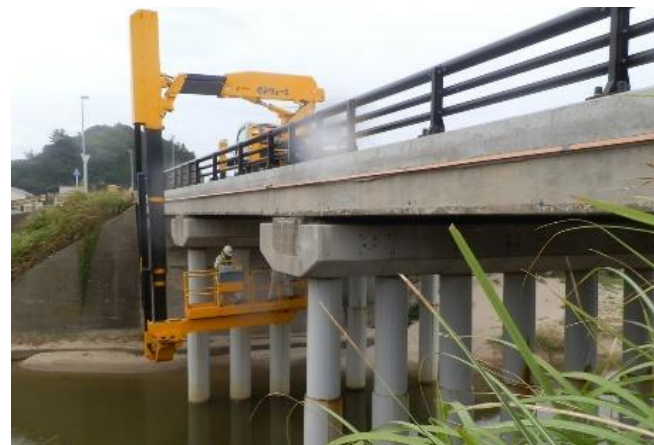
橋梁点検の様子
