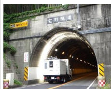
走行計測状況
