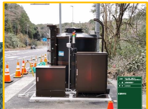
散布装置本体設置状況
