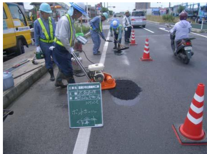
舗装の応急補修(ポットホール補修)
