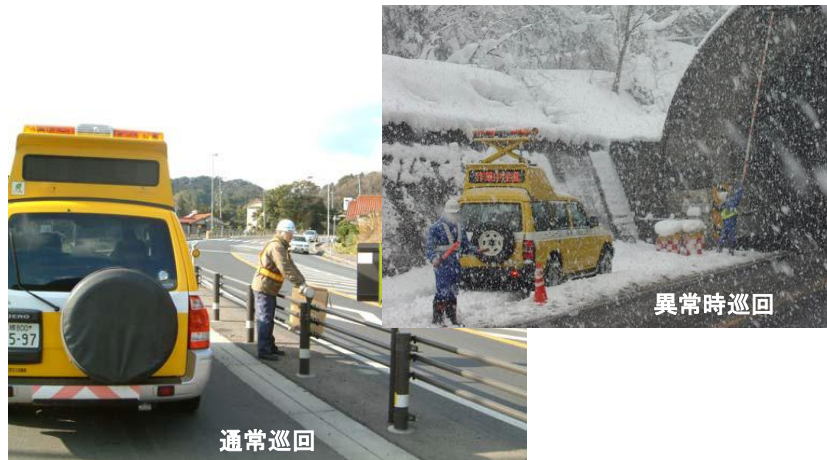
道路巡回 (通常巡回 9号、54号は1回/2日、山陰道は1回/日)
