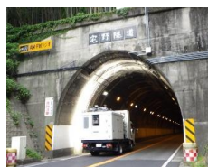
走行計測状況
