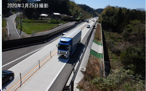
写真 多伎・朝山道路利用状況
