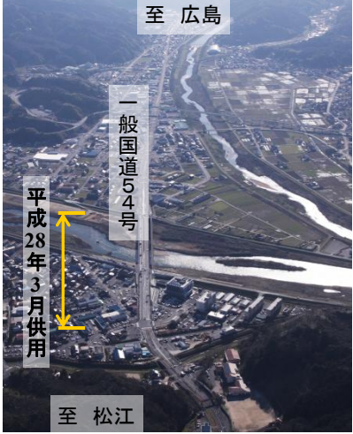
上空より里熊大橋周辺を望む
