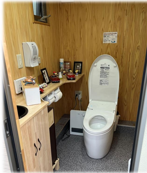
建設現場に設置された快適トイレ
