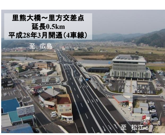
里熊大橋 広島方面を望む
