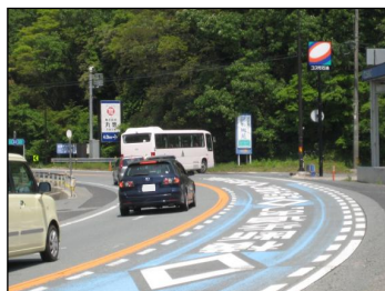
【大田市温泉津町福光】 一般国道9号 福光交差点改良
