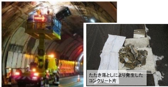
【写真①】赤名トンネル緊急点検の様子(令和3年1月)
